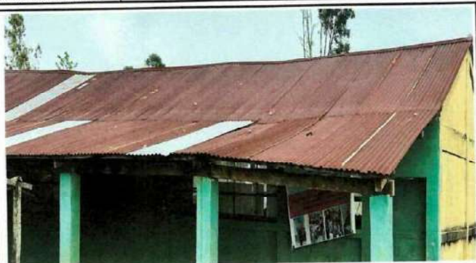
Foto 1: Sustrucción de cubierta de láminas.
