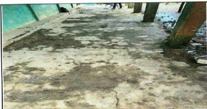
Foto 4: Sustrucción de piso de torta de cemento.
