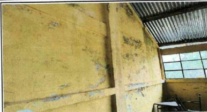
Foto 2: Aplicación de pintura en su interior y exterior.
