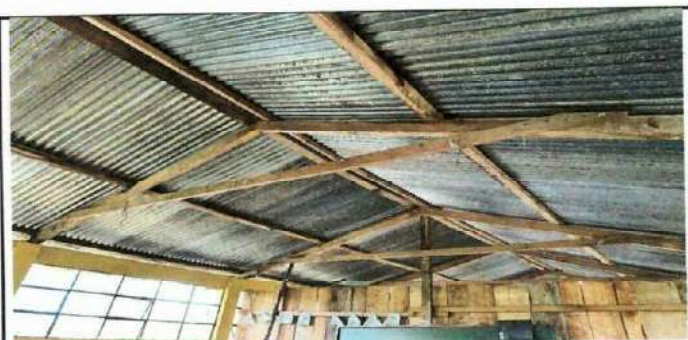
Foto 5: Sustrucción de la estructura del techo.
