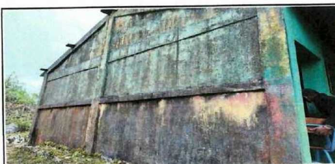
Foto 6: Mantenimiento de paredes y columnas.
